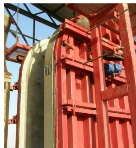
Стадион Аль-Анбар / ИРАК Подпорная стена
